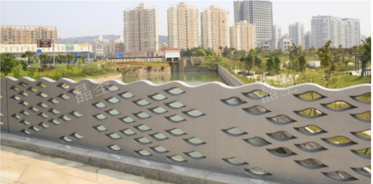
晶铸石景观护栏表面密封的这几种方法：对晶铸石景观护栏密封空缝，进行不加密胶的封闭。在晶铸石景观护栏表面形成空气对流，将蒸气排外，防止表面温差使晶铸石景观护栏内面不泛聚水。如涉及雨水的排出和方向问题，设计时应先考虑到，用在晶铸石景观护栏后应将雨或凝聚水排出墙外，可二或三层，每层有闸板排雨水。对晶铸石景观护栏用中性密封胶来封闭。将晶铸石景观护栏外立面的缝全密封，外立面的水无法进入背面，可以使密处于干燥，确保抗弯强度和抗压强度不变。要保证晶铸石景观护栏不结冰，不出现碱化，并保证建设的长久性。对晶铸石景观护栏密封用半密封的法子来封闭。保持晶铸石景观护栏外立面呈无密封胶的状态，这样外立面有立体感，实际是将胶藏在内部，但保证密封胶的厚度在5毫米以上，且不超过宽度，应按照胶的品质来进行决定。
